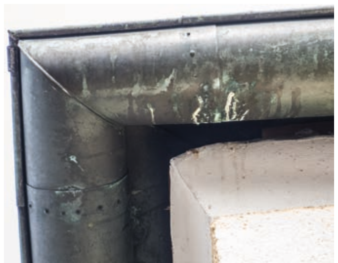
Hier braucht man ein geschultes Auge, um die Kotspritzer nicht mit Farb- oder Wasserspuren zu verwechseln.
